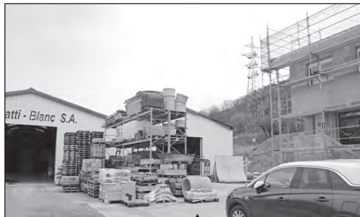
A droite le nouveau bâtiment, en voie d'achèvement
