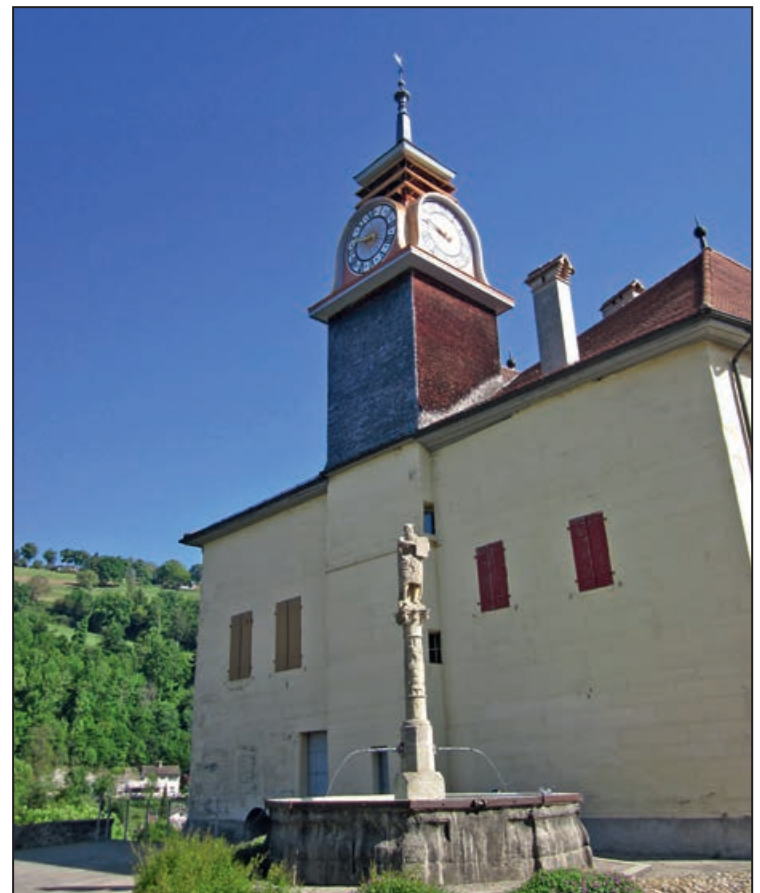
La tour d'horloge du Château du Rochefort rénovée
