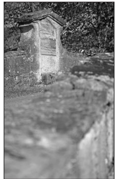
Le pont de Bressonnaz
