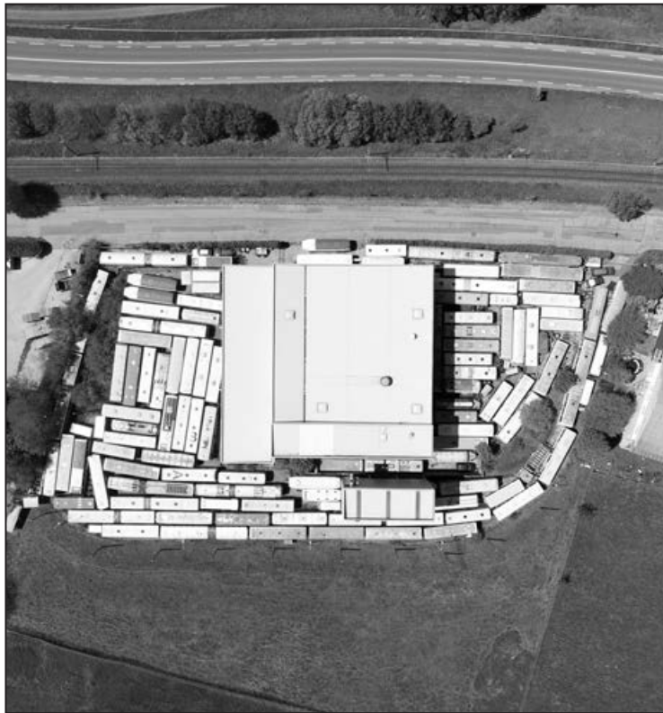
Vue aérienne du dépôt RétroBus au chemin de la Pussaz: saisissant!
